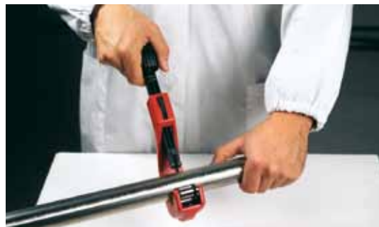
Bild 6 - Ablängen des Leitungsrohres
