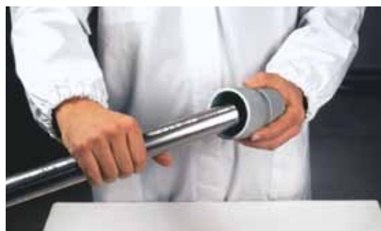
Bild 7 - Entgraten des Leitungsrohres
