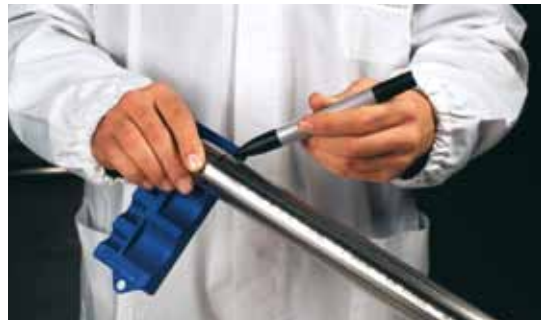
Bild 9 - Markieren der Einstecktiefe
